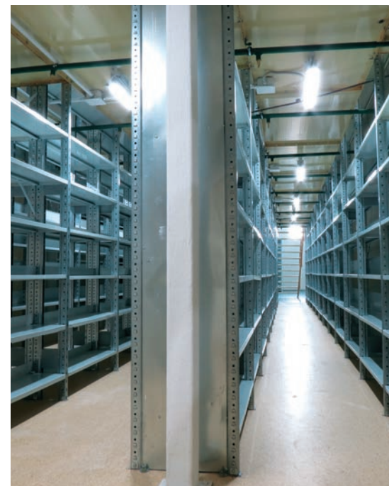
Освещение стеллажного хранилища «Учебно-Научной библиотеки УДГУ», Ижевск. В проекте применялись накладные светодиодные светильники «ЭЙФЕЛЬ»
