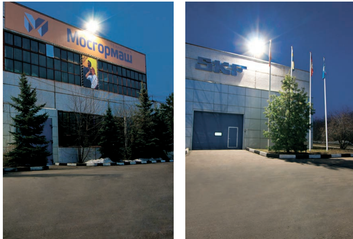
Освещение прилегающей производственной территории территории Технопарка «МОСГОРМАШ», Москва.
